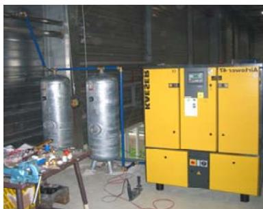
Der **Druckluft-Kompressor** besitzt ausreichende Leistung für die erste Etappe der Firmenentwicklung. Gleich in die Planung mit aufgenommen sind der Stellplatz und die Anschlüsse für einen zweiten Kompressor. Der neue Produktionsstandort der Napac AG ist gerüstet für eine spätere Erweiterung der Produktionskapazität mit zusätzlichen Maschinen
