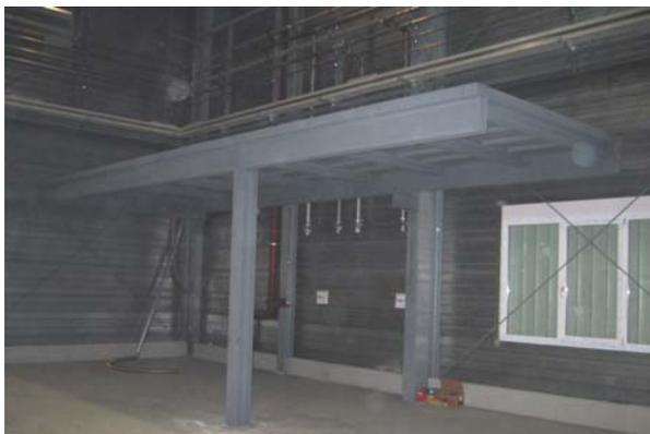
Podeste aus massiven Stahlträgern für Apparate und Anlagen der Versorgung
