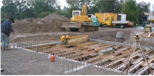
**Fundament**, für hohe Wind-Kräfte am Silo, unterirdisch begehbar
