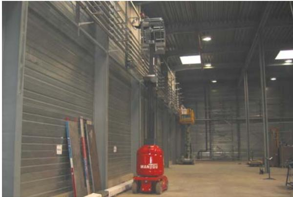
Ein **Trasse für die Rohrleitungen** in über 6 m Höhe versorgt sämtliche 12 Maschinen-Stellplätze mit den nötigen Medien (Strom, Kühl-Wasser Druckluft, Vakuum und Abluft-Entsorgung)
